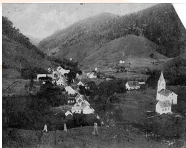
Figura 2: Igreja com Torre 100
